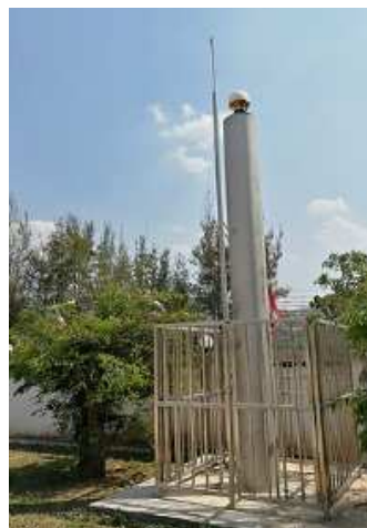
รูป ๒ - ๑ ตัวอย่างเสารับสัญญาณของสถานีรับสัญญาณดาวเทียมอ้างอิงของกรมที่ดิน
