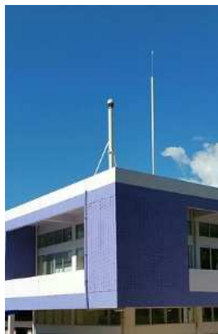
รูป ๒ - ๑ ตัวอย่างเสารับสัญญาณของสถานีรับสัญญาณดาวเทียมอ้างอิงของกรมที่ดิน
